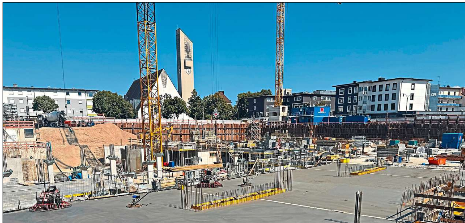
Das zweite Untergeschoss der Tiefgarage ist großteils fertig, parallel wird bereits am ersten Untergeschoss gearbeitet. Dieser Bau soll bis zum Jahresende abgeschlossen sein.
